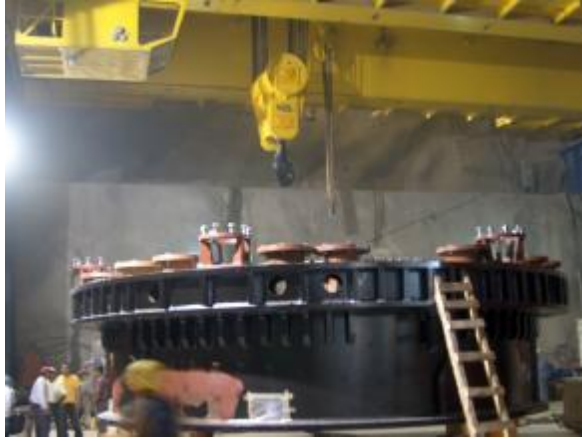
Vista de la grúa de 400 toneladas y parte turbina 2, a Mayo del 2006.
