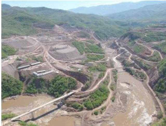
Vista aérea del lugar de construcción de la planta, en su comienzo.
