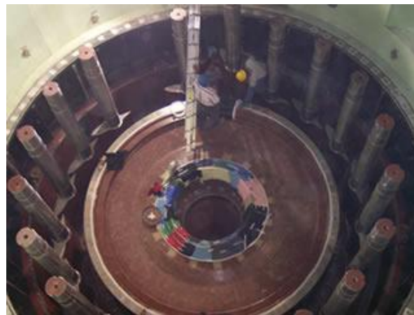
Armado de turbina No. 2, en Abril 2006.
