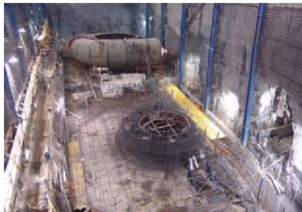
Vista de casa de máquinas en construcción.
