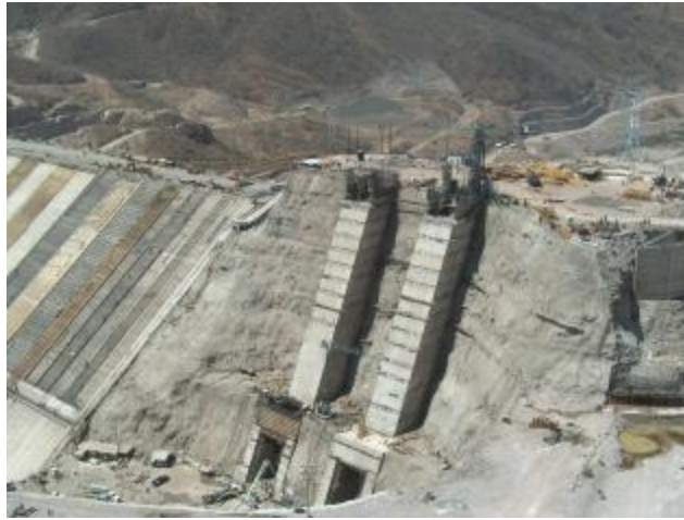
Construcción de la cortina y bocatomas a Mayo del 2006.
