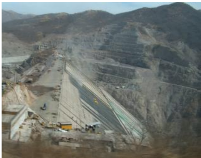
Construcción de la cortina a Mayo 2006.
