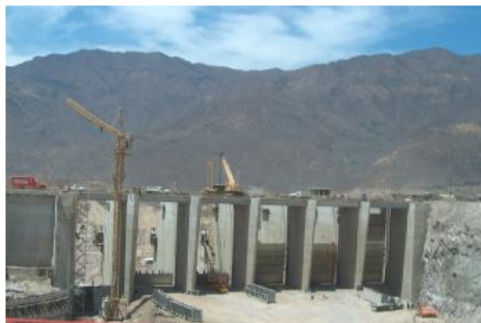
Vista del colado de las pilas del vertedor en Mayo del 2006.
