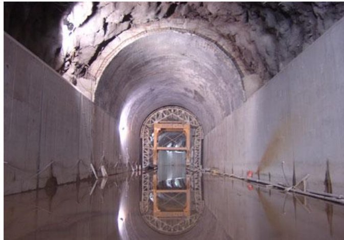
Vista cimbra metálica en túnel de desfogue
