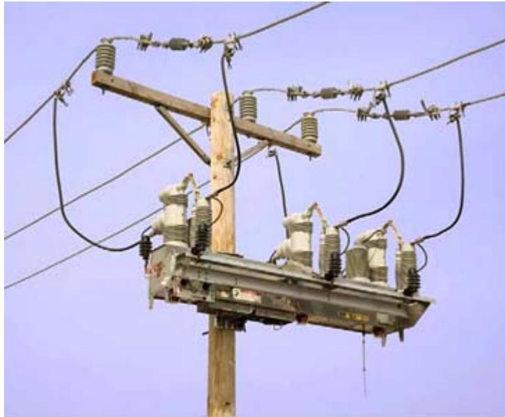
Para evitar el pleno cierre en condiciones de falla, un fabricante ha diseñado un restaurador que cierra el circuito solamente con un pulso de prueba, con una duración de 5 milisegundos (un poco menos de medio ciclo). Si el circuito ya no tiene falla, se inicia el proceso común de cierre, quedando bloqueado en caso contrario.
