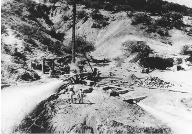
Pozo No. 1 en campo Geotérmico de Pathé, Hgo.
