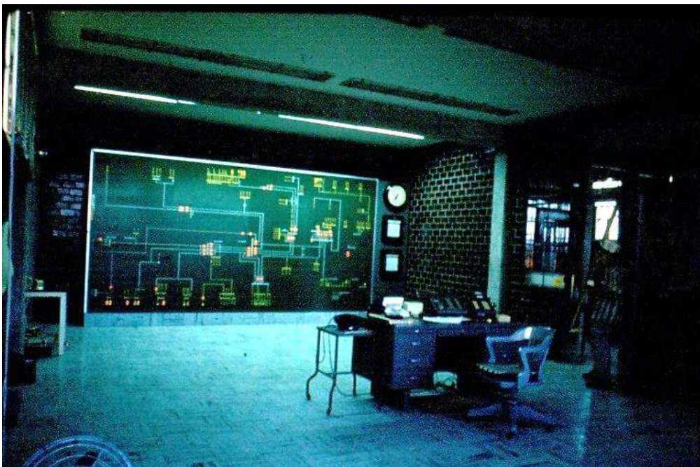
Fotografía del primer tablero mímico del Sistema Interconectado de Guanajuato el día que se le trasladó la comunicación por radio a principios de la década de 1960. Estaba ubicado en la subestación Arandas, en Irapuato, Guanajuato.
