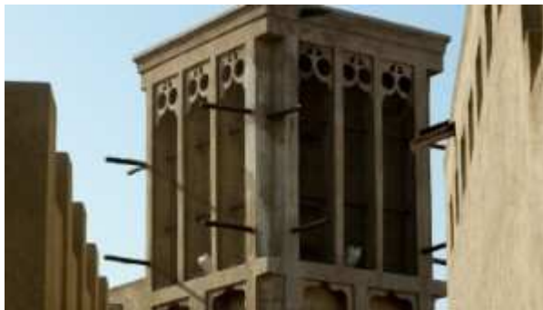
Torre árabe tradicional para ventilación.
