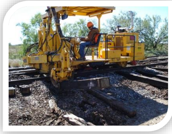
Foto de la máquina que cambia durmientes.
