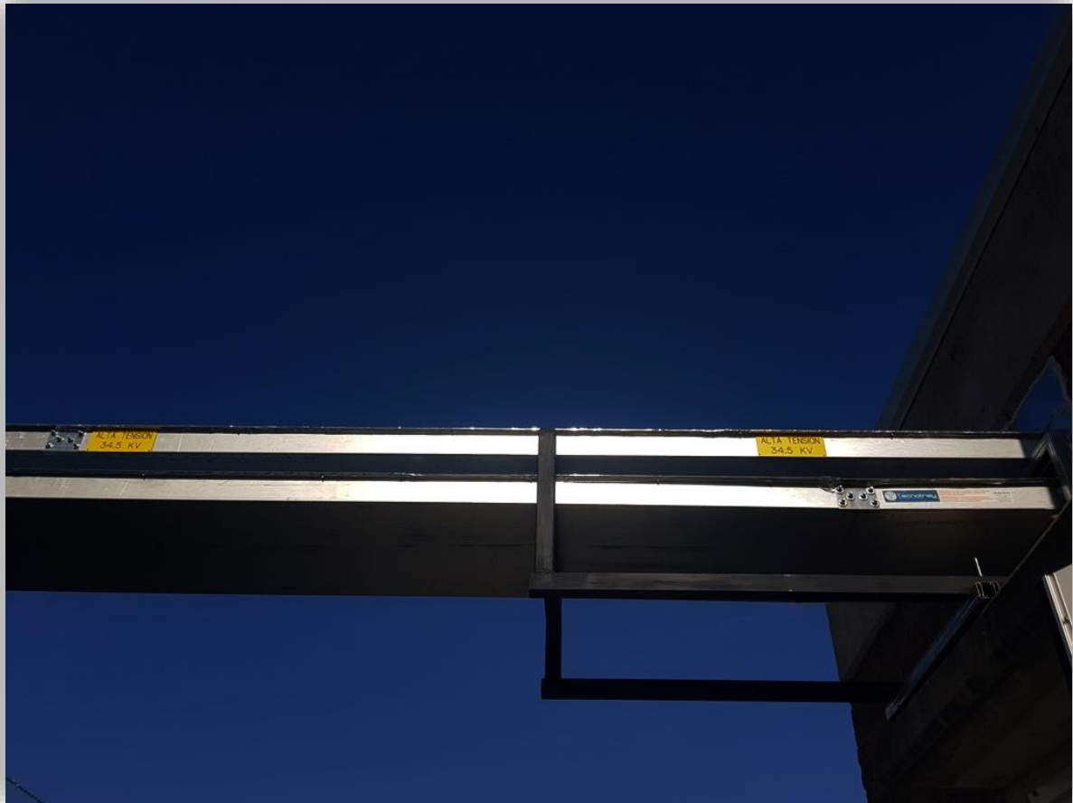
392-18. Instalación de charolas portacables.
