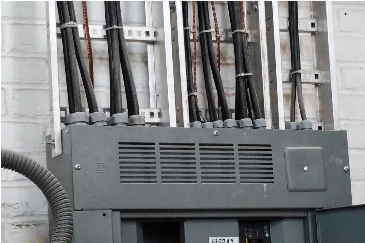
**300-20. Corrientes inducidas en envolventes metálicas ferrosas o canalizaciones metálicas ferrosas.**
