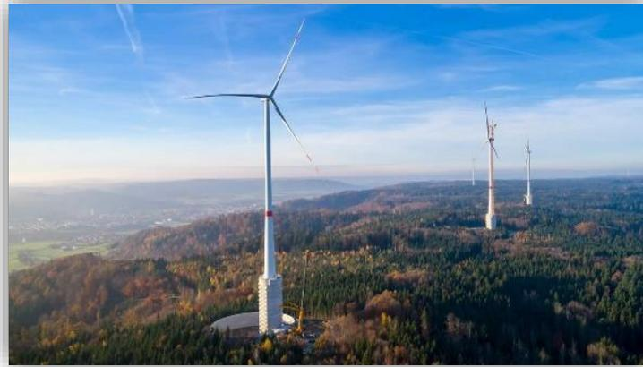
La planta eólica consiste en 4 turbinas GE-137 de 3.4 MW que se estima producen 42 GWh por año. La base de las turbinas es hueca para contener 40 000 metros cúbicos de agua hasta una altura de 40 metros. Las bases de las turbinas están inter conectadas por una tubería de poco más de 1 metro de diámetro.
